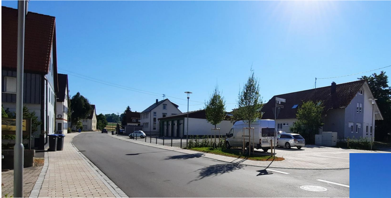
Neugestaltung Rathausstraße (4. Bauabschnitt)
